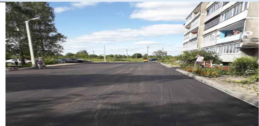
Ремонт дворовой территории ул. Вагжанова
