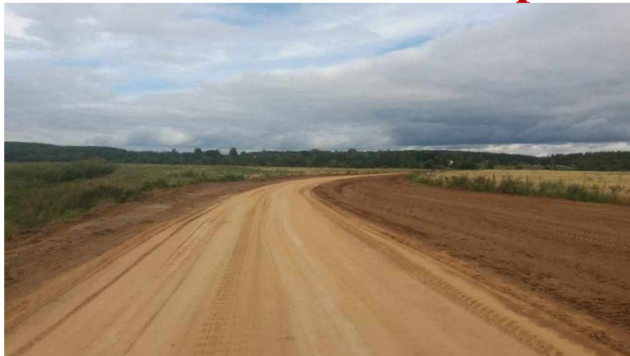
Ремонт участка автомобильной дороги д. Старо-Курцово - Ново-Курцово
