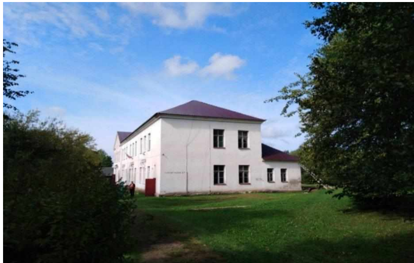
Ремонт кровли МБОУ «Луковниковская СОШ»
