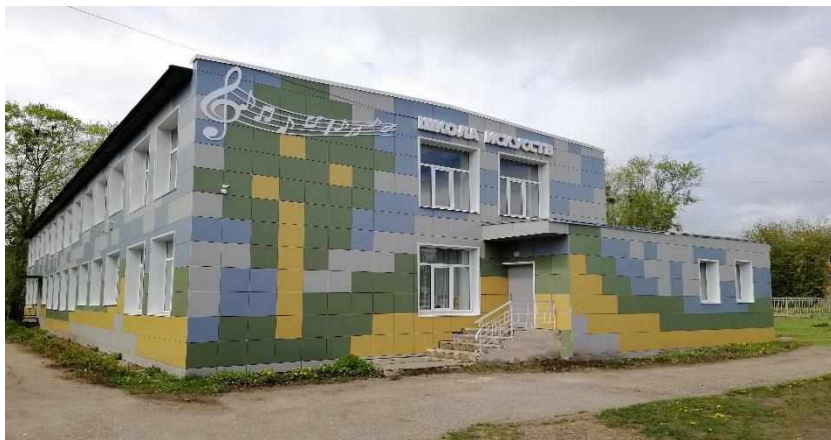
Ремонт фасада МБУДО «Старицкая ДШИ»
