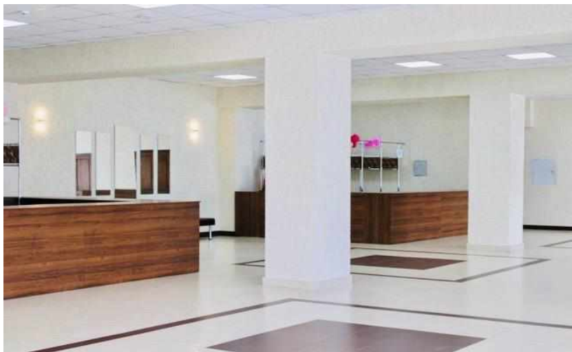
Ремонт МБУК «РДК им.Я.С. Потапова»
