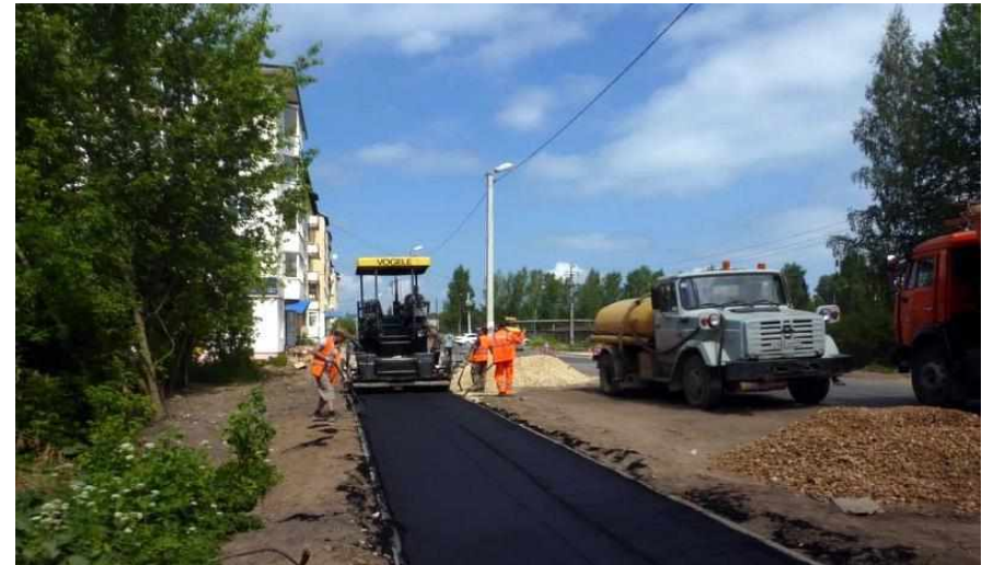
Ремонт дороги по ул. Пионерская
