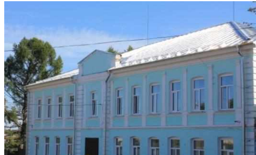
Ремонт кровли МБОУ «Старицкая СОШ»
